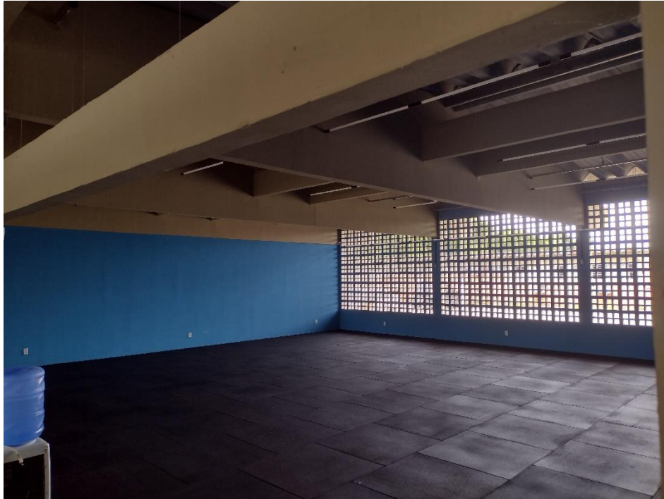
Figura 3 – Área Crossfit Visão Geral. Concluída.
