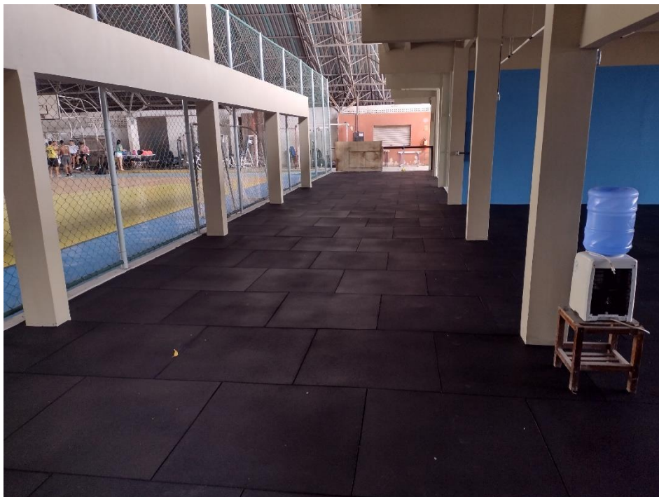
Figura 2 – Área Crossfit Visão geral. Concluída.
