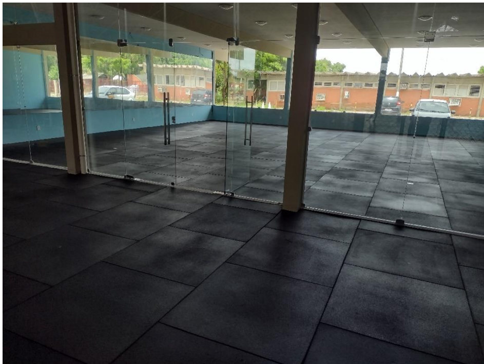
Figura 6 – Piso emborrachado. Concluído.
