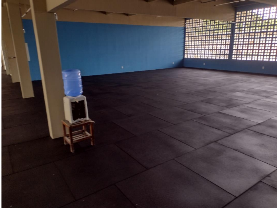
Figura 5 – Área Crossfit . Piso emborrachado. Concluído.
